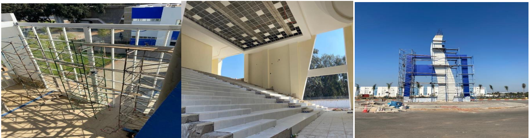
Photos : Travaux de construction et d'aménagement à la FEG-Kenitra
